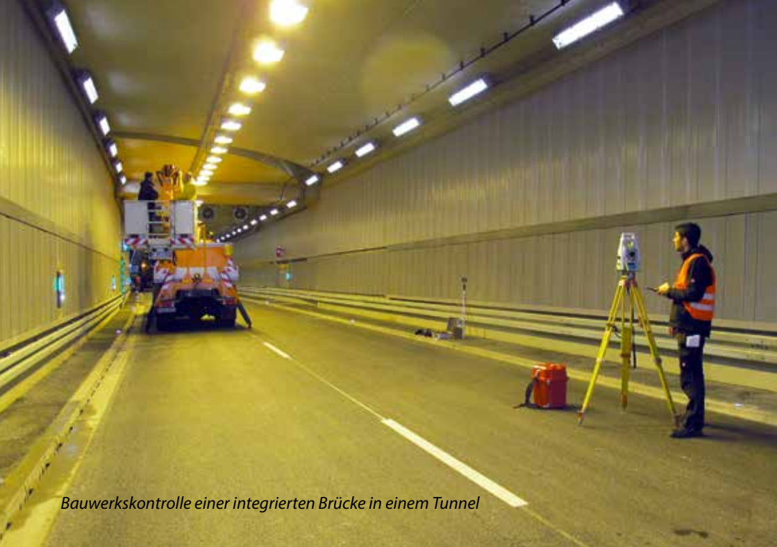
Aufmaß einer Tunnelrampe
