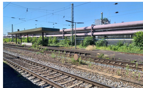
Abb. 3.1.19-2: Mittelbahnsteig vor dem Umbau.
