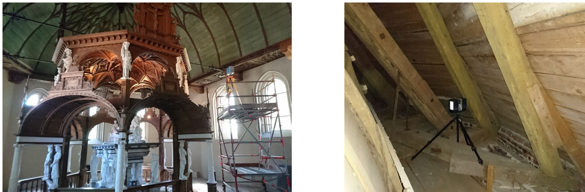
Abb. 3.1.6-2: Aufmaß des gesamten Bauwerks mit 3D-Laserscanning.
