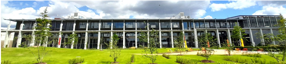
Abb. 3.1.21-1: Ehemalige Industriehalle des Factory Campus nach der Fertigstellung 2023.
