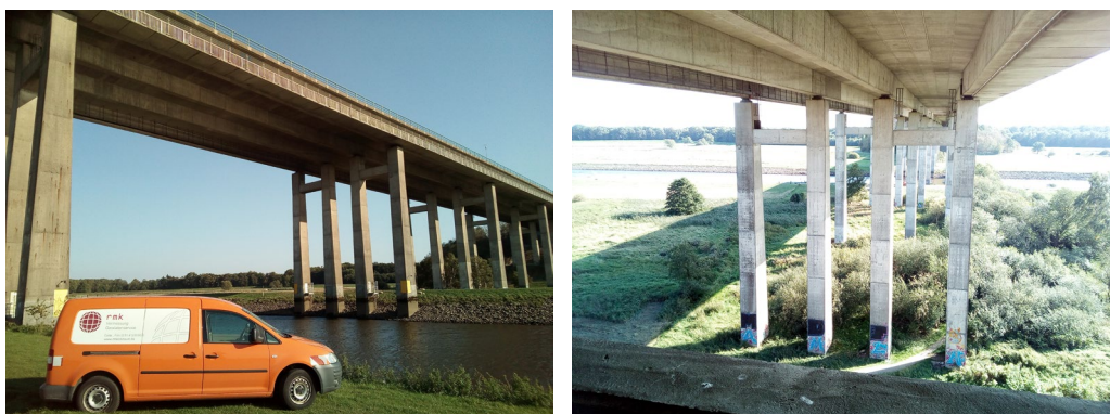
Abb. 3.1.10-1: Huntebrücke bei Oldenburg (A29).
