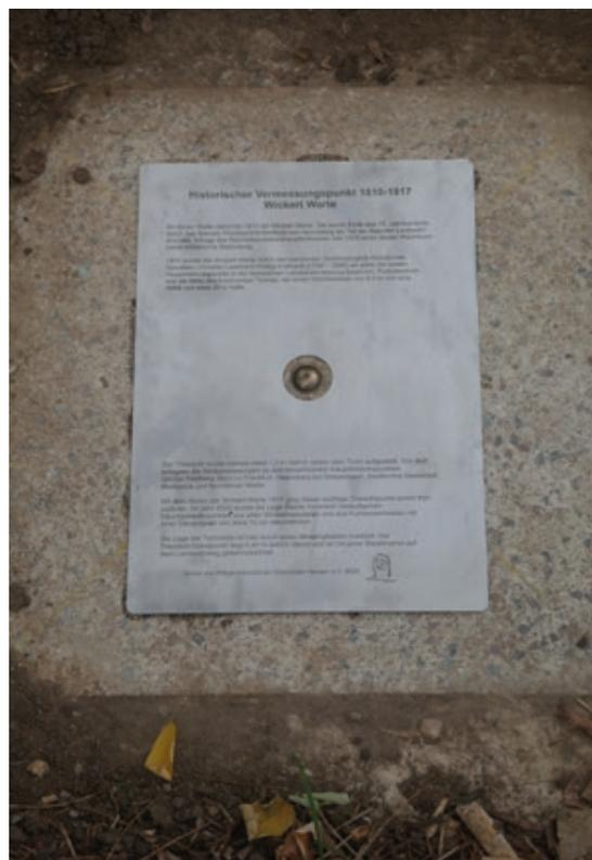
Abb. 18: Zentrum Z (Betonplatte mit 3D-Bolzen und Metallschild mit Informationen zum DH-Dreieckspunkt Wickert Warte)
